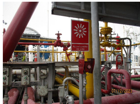
ภาพที่ 2-24 การติดตั้งสัญญาณเตือนเหตุเพลิงไหม้บริเวณพื้นที่คลัง และท่าเทียบเรือ
