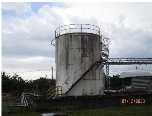
ภาพที่ 2-8 ถังเก็บรวบรวมน้ำมันจากบ่อดักไขมัน (Slop Tank)
