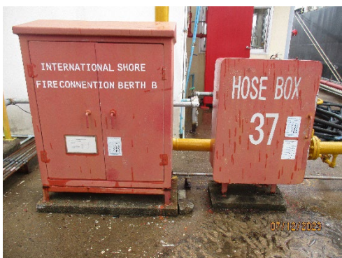
ภาพที่ 2-22 การติดตั้งอุปกรณ์ป้องกันระงับเหตุอัคคีภัยและอุปกรณ์ล้างตาฉุกเฉิน ภายในบริเวณพื้นที่ท่าเทียบเรือ
