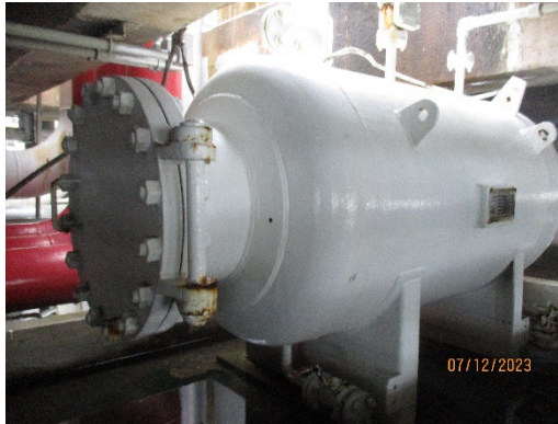
ภาพที่ 2-6 ถังเก็บรวบรวมน้ำเสียบริเวณหน้าท่าเทียบเรือ
