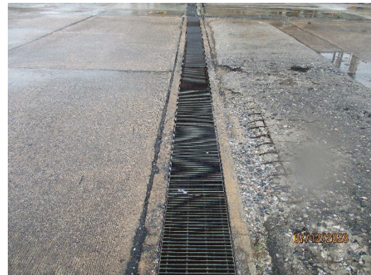
ภาพที่ 2-7 รางระบายน้ำภายในพื้นที่โครงการ
