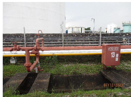
ภาพที่ 2-21 (ต่อ) การติดตั้งอุปกรณ์ป้องกันระงับเหตุอัคคีภัยและอุปกรณ์ล้างตาฉุกเฉิน ภายในบริเวณพื้นที่ปฏิบัติงานคลัง
